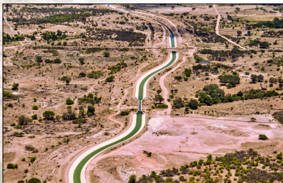
Canal do Sertão Baiano Fonte: Geohidro Consultoria
